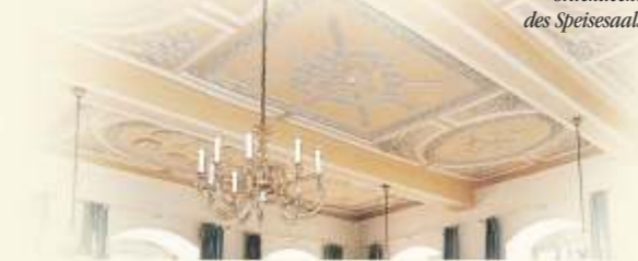
Stuckdecke des Speisesaals
